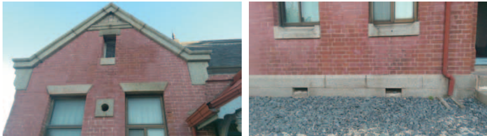
日式建築通風對流構造
