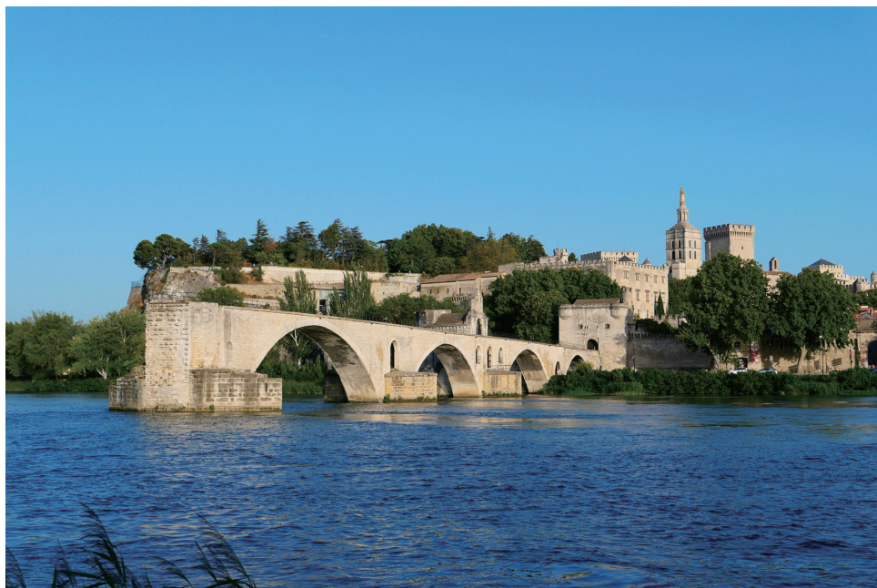
原本的聖貝內澤橋長約九百米，擁有二十二個拱孔，經過洪水災害後，僅存四個拱孔，成為現今的阿維尼翁斷橋
